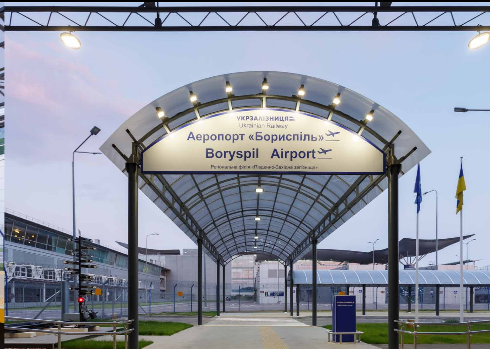
Станція Аеропорт «Бориспіль» | УЗ
