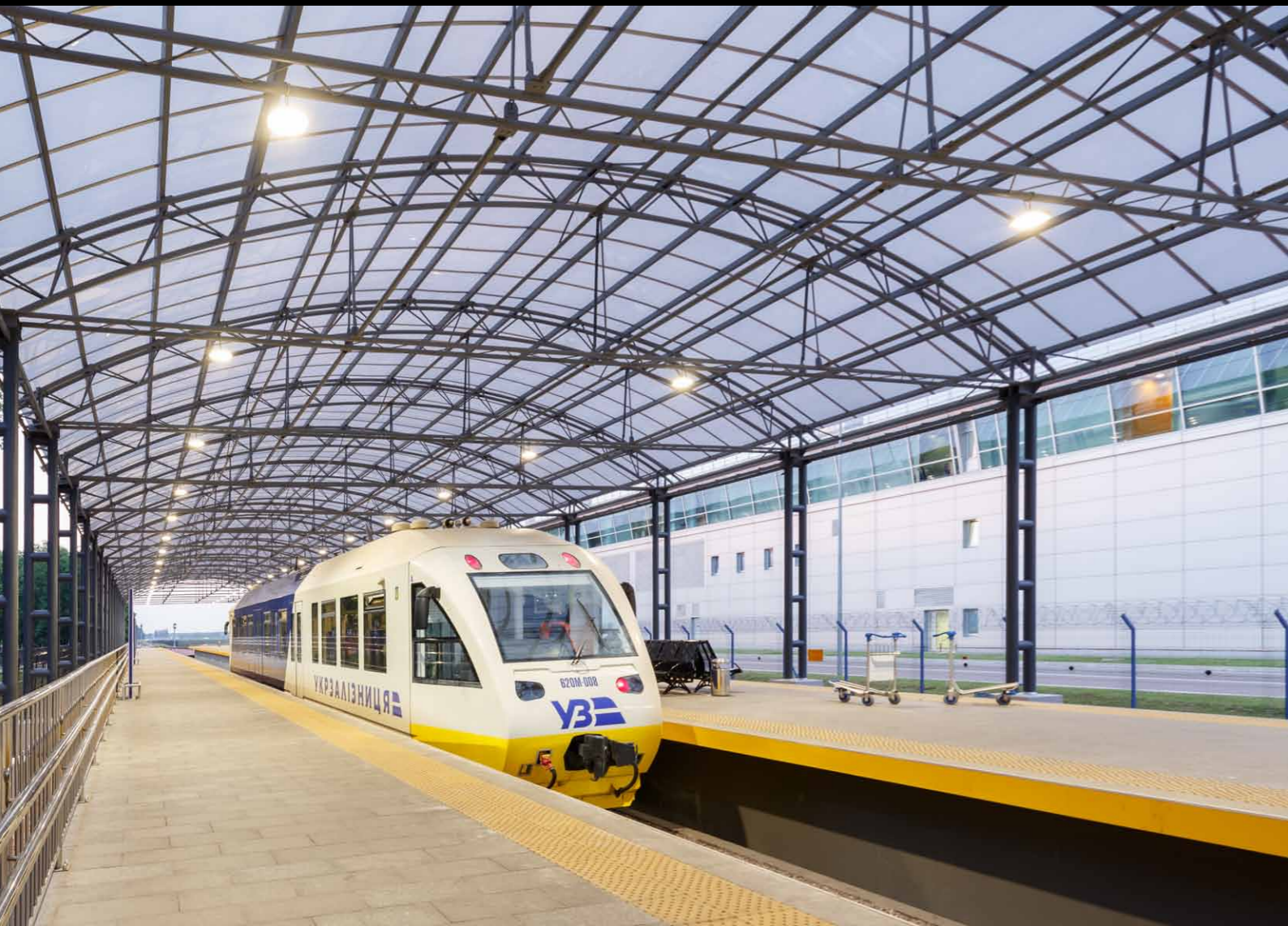
Станція Аеропорт «Бориспіль» | УЗ
