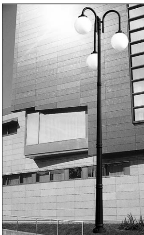
Опора вулична SP-4 W висотою 4,76 м
